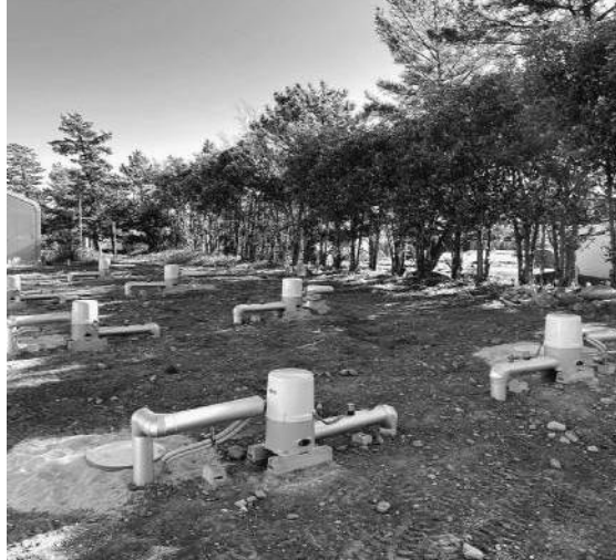
イノベックスの工場に導入した熱源孔。深さ100メートルの熱源から合計200キロワットの出力が可能(静岡県袋井市)
